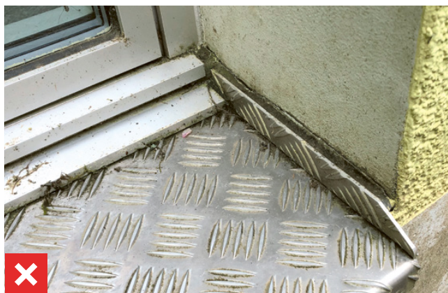
Abb. 20 Stehbord mit horizontaler Fuge
