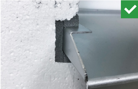
Abb. 45 mit exaktem Dämmstoffausschnitt und Fugendichtungsband BG 1
