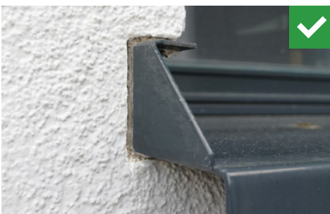
Abb. 49 mit überputztem Fugendichtungsband
