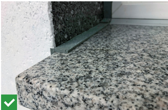
Abb. 53 Vorgelegtes Fugendichtungsband in der Leibung als Vorbereitung für Passstück
