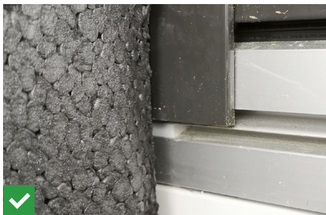
Abb. 19 Mit Dichtstopper verschlossene Nute
