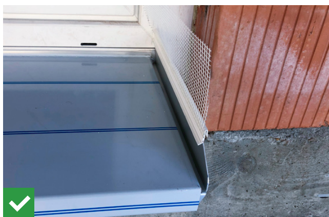
Abb. 22 Entkoppeltes Stehbord mit aufsteckbaren Putzabschlussprofilen
