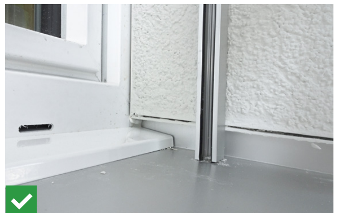
Abb. 13 Putzbordanschluss mit Putzabschlussprofil mit integriertem Fugendichtungsband
