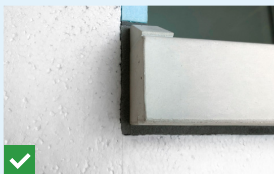
Abb. 59 Anschluss mit umlaufendem Fugendichtungsband BG 1
