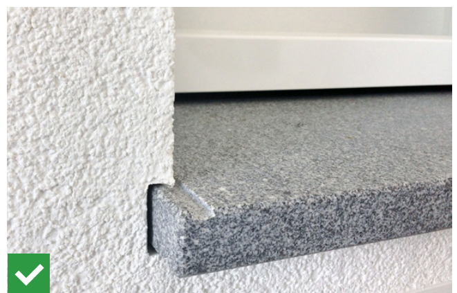
Abb. 55 Steinbank ohne Putz- oder Stehbord mit eingefräster Nute in Kombination mit Einschubprofil und Sekundärabdichtung
