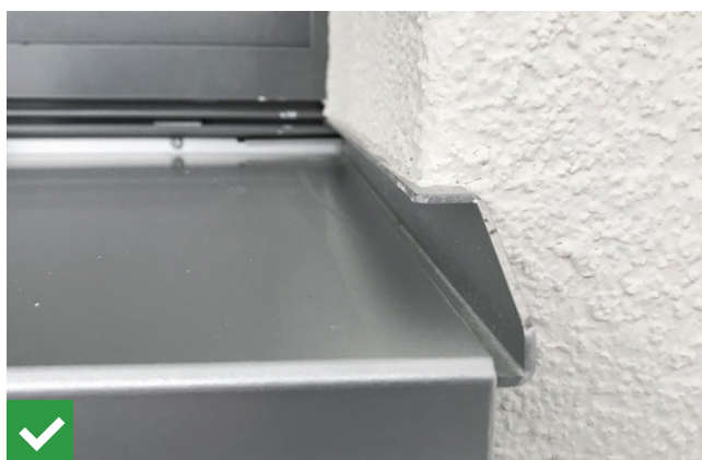
Abb. 21 Entkoppeltes Putzbord mit vorhandener Dehn- und Stauchzone
