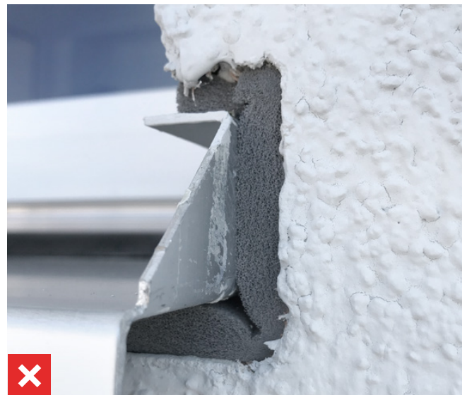
Abb. 38 Ums Eck gezogenes Fugendichtungsband
