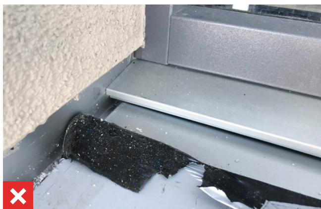
Abb. 44 Zu langer Wetterschenkel bei entkoppeltem Putzbord
