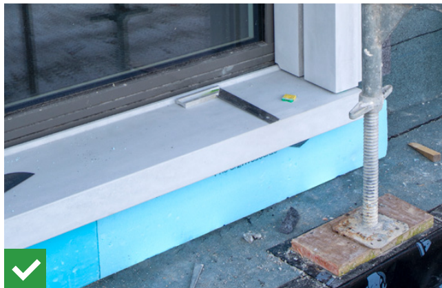
Abb. 33 Türschwellenaullager mit satt aufliegenden XPS-Dämmplatten
