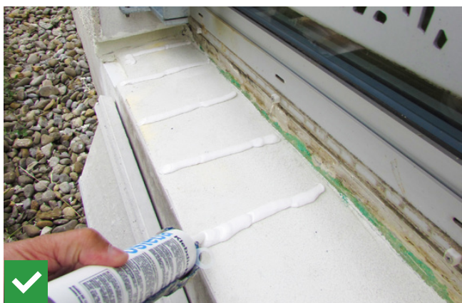
Abb. 32 Auftrag von Kleberaupen auf Auflager aus bewehrter, systemkonformer Grundputzschicht
