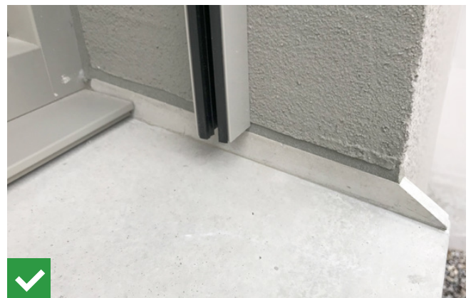
Abb. 12 Putzbordanschluss mit sichtbarem Fugendichtungsband
